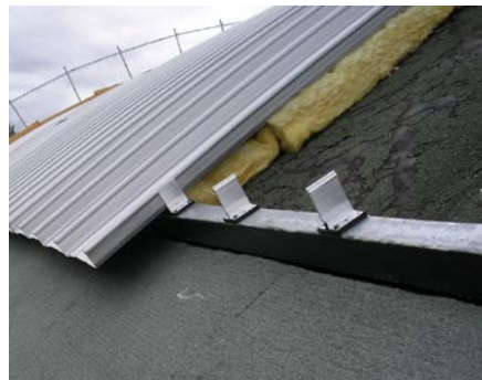
Isolation toiture
