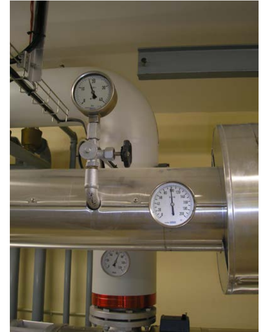
Relevés température et pression circuits de chauffage
